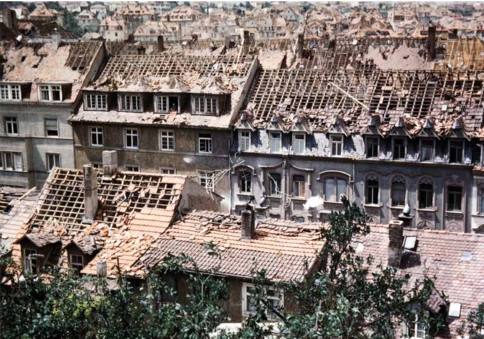
Vom Tornado abgedeckte Dächer in der Calwer Straße und der dahinterliegenden Seebergstraße (Sign. S1-12-1-6-V-27; Fotograf: Werner Kraus)
